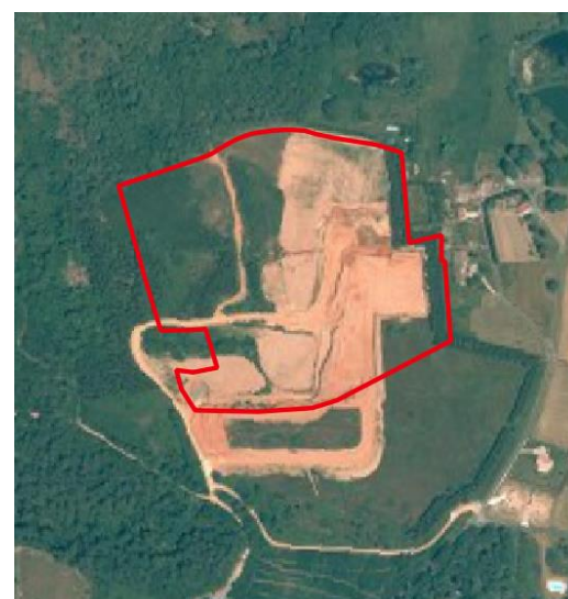
2005 : Expansion vers l'Est et le Sud de la carrière s'étalant sur toute l'AEI et re-végétalisation des zones pré-exploitées à l'Ouest
