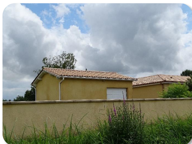
Maison récente, typique des villages avoisinants l'AEI
